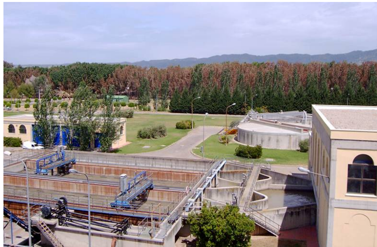
Figura 1. Barrera vegetal en EDAR
