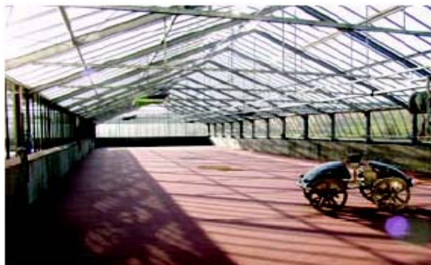
Figura 2. Instalación de compostaje solar
