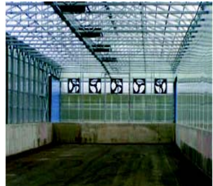
Figura 4. Renovación aire c/ ventiladores
